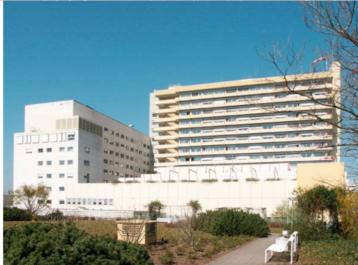
Die modernen medizintechnischen Geräte im Klinikum Ludwigsburg stellen hohe Anforderungen an eine zuverlässige Hydraulik des Kältesystems und an bedarfsgerechte Durchflussmengen.
